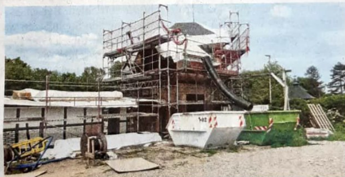
Noch ist das Dreienbrunnenbad eine Baustelle.
